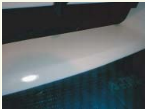
FRPの硬化後、アルミテープをはがしてパテで成形し、磨いて塗装で仕上げれば完成です。
